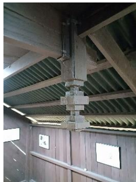
Gambar 2, Tiang gantung yang terdapat pada Rumah Datuk Diwangsa di Muzium Warisan Melayu, Universiti Putra Malaysia
