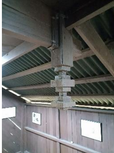
Gambar 2, Tiang gantung yang terdapat pada Rumah Datuk Diwangsa di Muzium Warisan Melayu, Universiti Putra Malaysia
